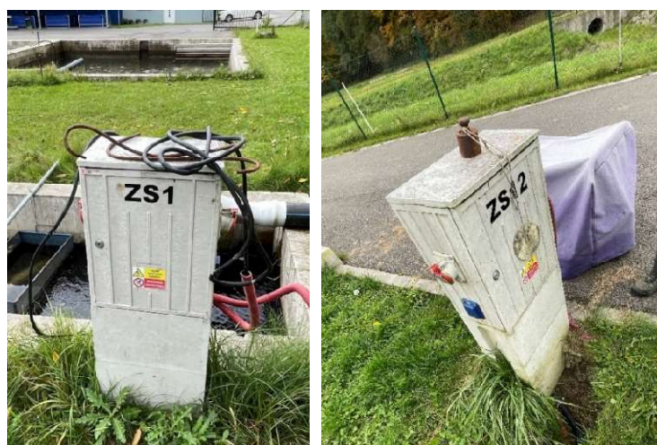
Obrázek 5 Stavební rozvaděče ZS1 a ZS12
